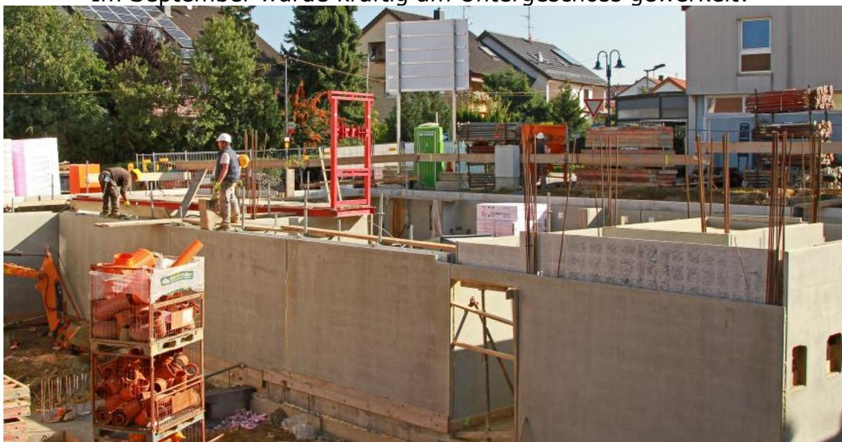
Es wurde jede Menge Eisen verbaut und noch im September war die Oberkante vom Untergeschoss fertig. Mit Betonfertigteilen wurde begonnen das Erdgeschoss und die weiteren Geschosse aufzubauen.
