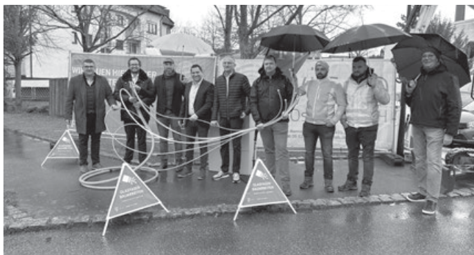
März – Glasfaserausbau Spatenstich Telekom
